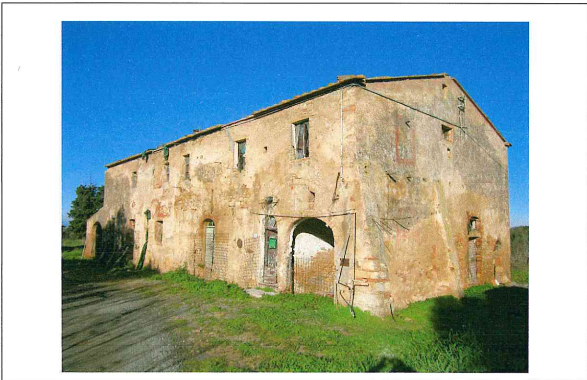
Foto 2: Vista lato sud/est
