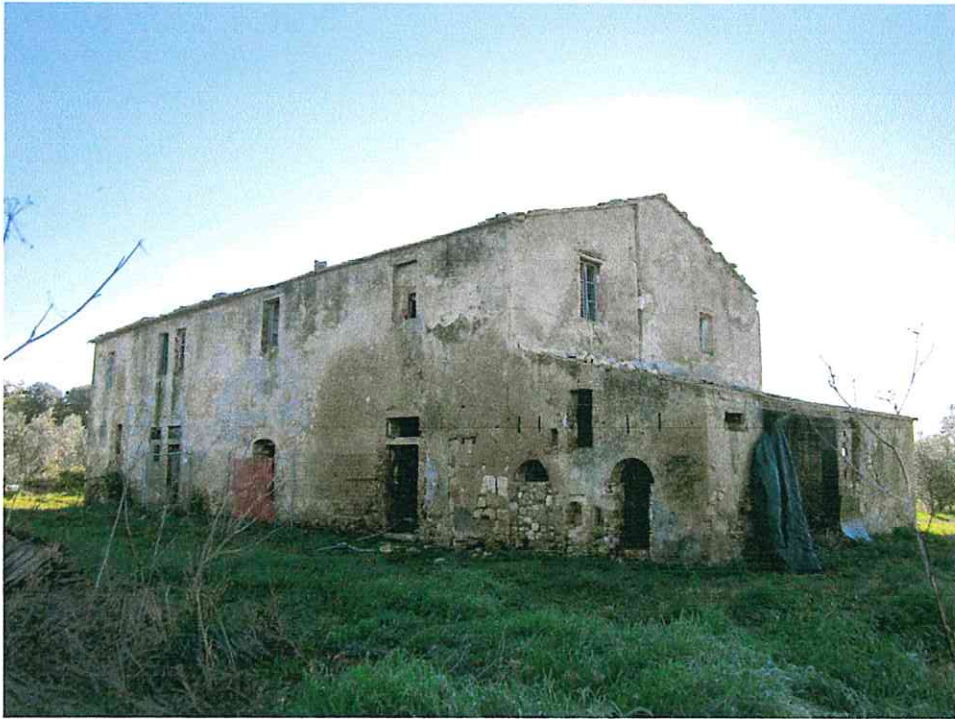
Foto 5: prospetto nord/ovest – prima del crollo
