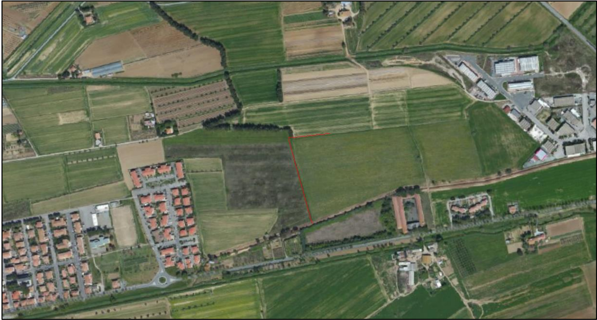
Figura 81 Argine di contenimento delle acque provenienti da una rottura arginale nella zona del Mannaione
